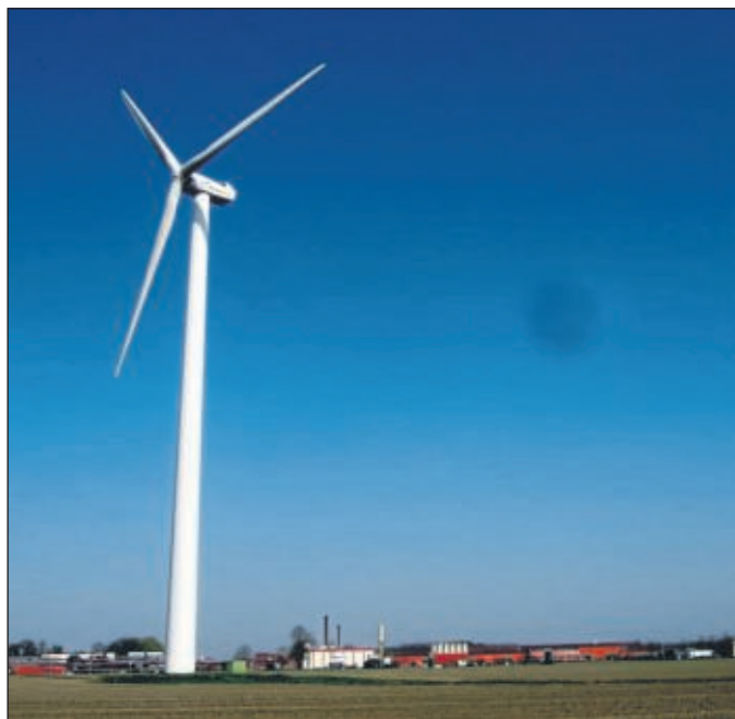
Die Windenergieanlage in Aldrup ist nahe am Betrieb „Agrarfrost“ gelegen. Sie darf nicht erneuert werden. ■ Foto: Rohdenburg
